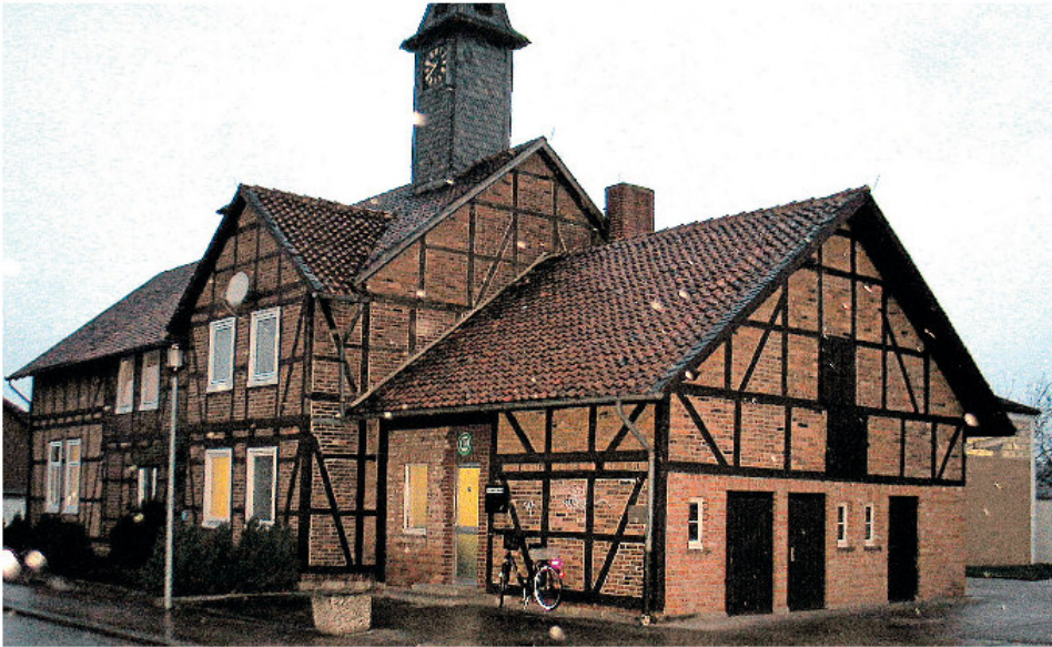
Das Dorfgemeinschaftshaus in Essehof ist sanierungsbedürftig – und das schon seit einigen Jahren. Archivfoto: Werner Kison
