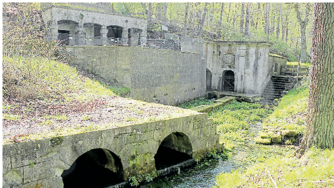
Wie der historische Bereich der Lutterquelle saniert werden kann, soll erörtert werden.
